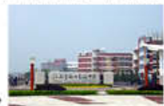
省锡中行政楼装修工程（紫金杯）
