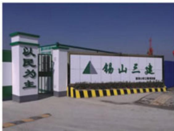
定型化门头：由钢结构组装而成，外包铝塑板。外观大方，安装方便，周转简易。可重复使用。
