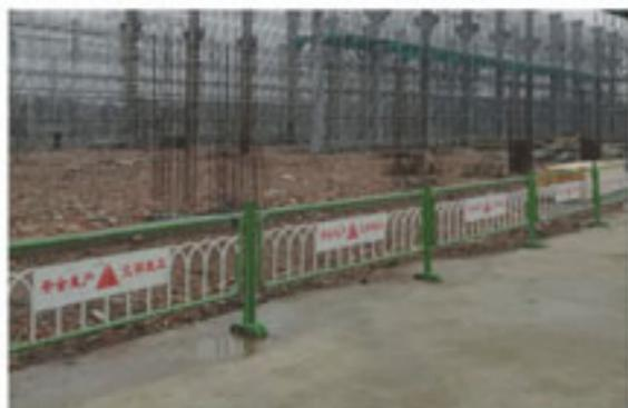
防护隔离栏杆：采用废弃市政用隔离栏杆改装而成，有效将施工区域进行分割，组装方便，观感大方。
