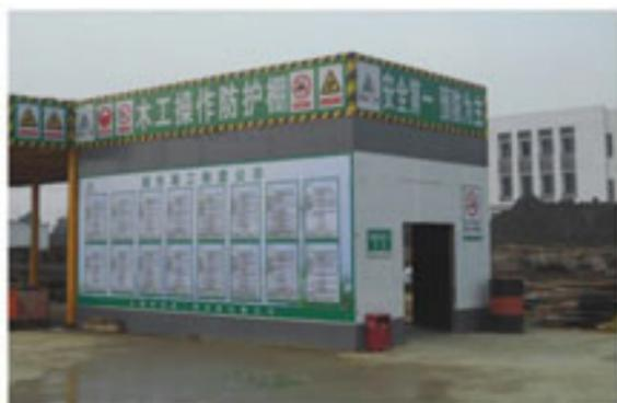
安全防护棚：现场钢筋、木工防护棚采用方钢及角钢进行制作，立柱底部采用膨胀螺栓进行固定。木工防护棚实用废弃模板进行全封闭。防护棚安全简易，外观大方，周转使用方便。
