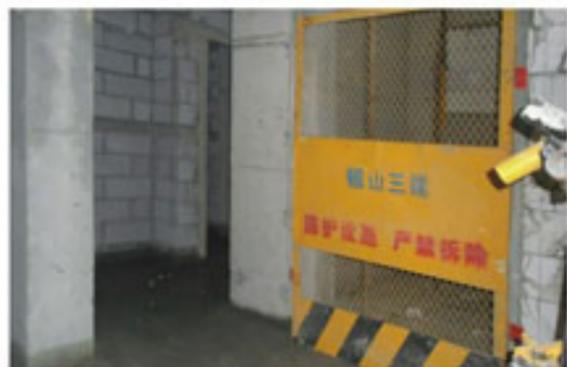
门式电梯井防护门：门式电梯井防护门是建筑施工现场预防人员伤害的必备防护设施，其结构简易，安装使用方便，观感大方，防护效果好。
