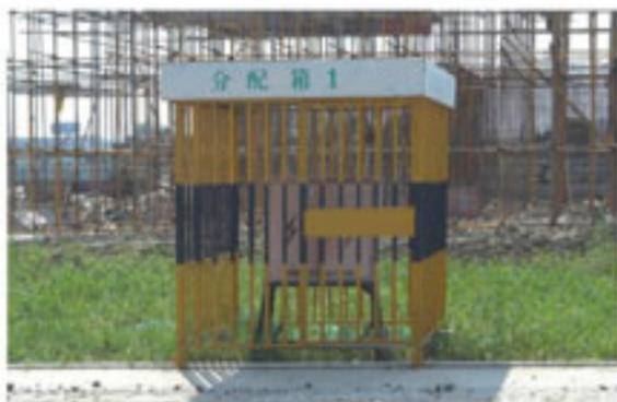
电箱防护棚：采用单片方钢焊接，采用自攻螺丝组装而成，顶部用彩钢瓦进行封闭，防雨效果好。安全简易、使用方便、周转方便。
