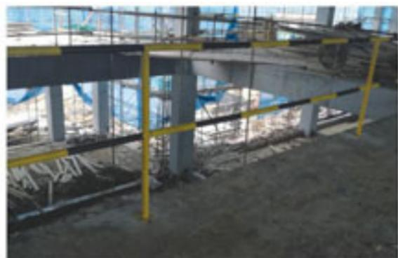
定型化楼梯扶手及临边防护：楼梯栏杆扶手及临边防护使用短钢管为接头，内插钢管后使用螺丝进行固定。立杆采用膨胀螺栓与结构进行固定。使用结束后可拆除重复使用，周转率高。
