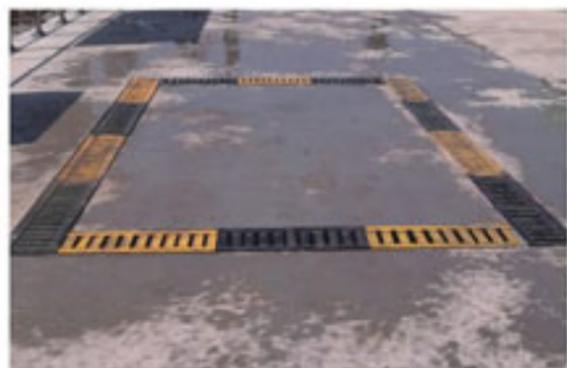
地沟盖板：适用于施工现场车辆冲洗池及排水沟上防护用。采用废弃角钢改装而成，牢固可靠，安全简易，周转重复使用率高。
