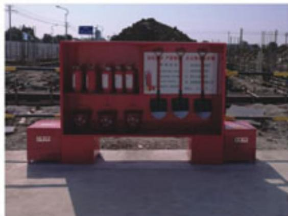
消防箱：现场消防箱采用钢结构设置三门用钢板封闭，安装简易，使用方便，运输简单。
