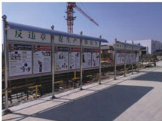
定型化宣传栏：采用不锈钢管材焊接而成，底部由膨胀螺栓固定，背部可设置斜撑。外观大方，安装简易，周转方便。
