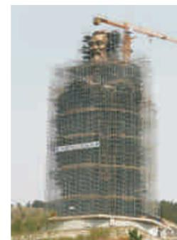
山东曲阜孔子像高达72米，为全国最高，该项目采用我公司新型盘扣架（承插型盘扣式脚手架）体系，是山东省重点文化旅游项目。目前，孔子像表面喷漆已完成30%，预计今年9月完工。
