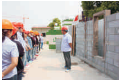
工地现场参观
