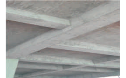
不同标高框架梁与连系梁主次交叉，节点清晰；无漏浆，无缺棱掉角现象。
