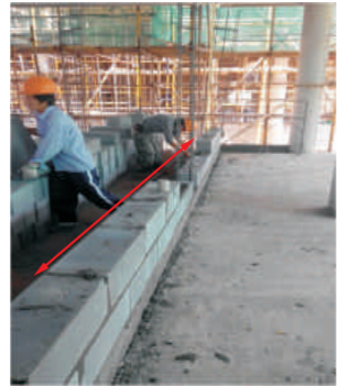
拉通线砌筑，确保墙体灰缝平直度。
