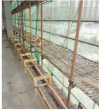
混凝土导墙模板采用方木卡箍与步步紧结合，形成足够刚度、强度、稳定性。
