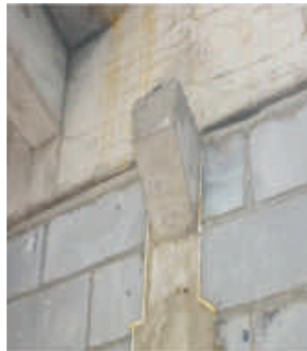
构造柱柱顶与梁底；模板采用簸箕漏斗，确保构造柱混凝土密实和与梁底紧密结合；杜绝该部位二次浇筑或修补。
