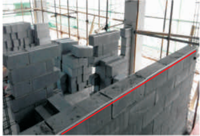
腰梁模板安装前事先贴好双面胶，防漏浆。
