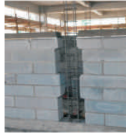
腰梁完成，上部砌体砌筑中；构造柱先退后进，同时倒角。构造柱钢筋居中设置，符合规范要求；腰梁脱模后几乎无漏浆现象。
