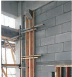
构造柱柱顶与梁底；模板采用簸箕漏斗，确保构造柱混凝土密实和与梁底紧密结合；杜绝该部位二次浇筑或修补。
