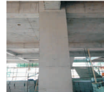
梁柱节点清晰，框架柱尺寸准确，棱角分明。
