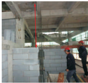
腰梁下部砌筑，构造柱先退后进拉垂直线；@500放置2根6.5圆拉结筋。
