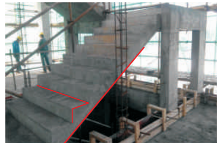
楼梯间踏宽、踏高尺寸方正，阴阳角棱角分明；未出现阴角凹陷；踏步表面细条纹拉毛；观感极好有助于后续面层粘结。
