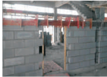
腰梁模板采用卡箍固定，确保脱模后截面尺寸。
