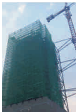
现场安装完密目安全网
