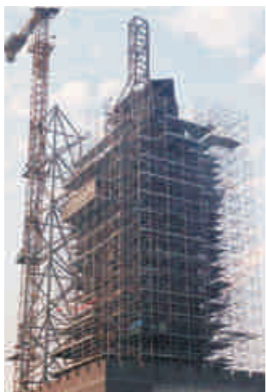
脚手架搭设到人像肩部
