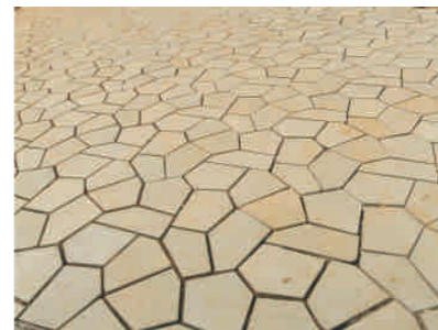
石材纹路齐整、缝隙宽度均匀
