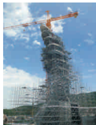
速捷架搭设过程中
