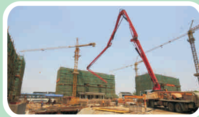
廊下花园安置房 施工高峰期
