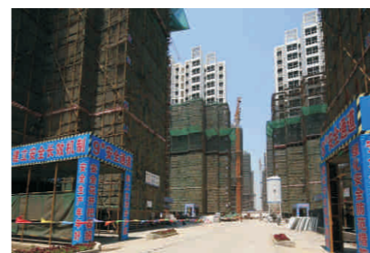
外脚手架正拆除中
