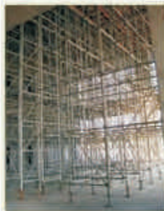
建筑施工承插型 盘扣式钢管支架应用
