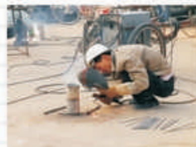
DN100镀锌管焊接
