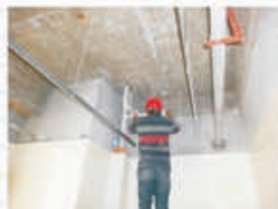
卫生间排水管道安装
